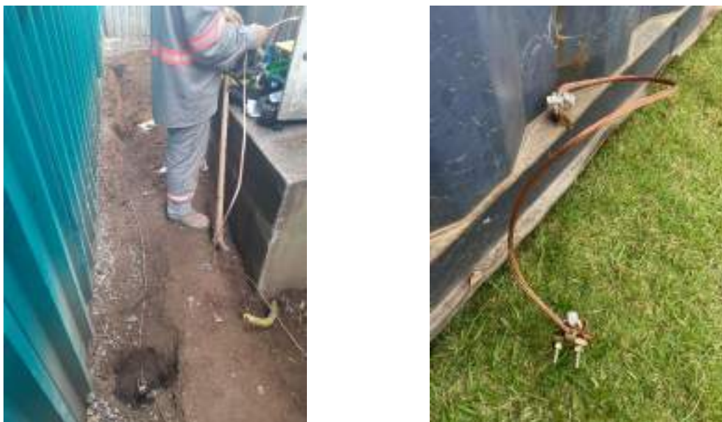
Figura 70 Inspeção e melhoria de instalações SPDA
