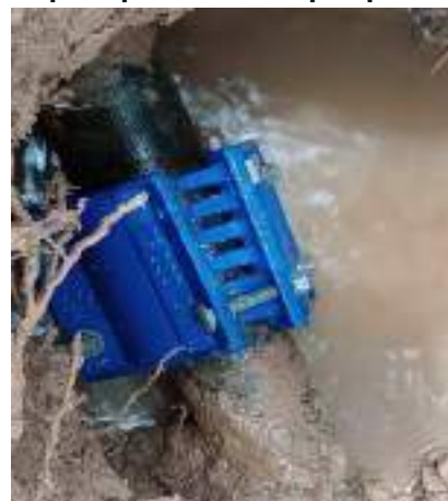
Figura 77 Reparo em tubulação rompida próximos ao parquinho
