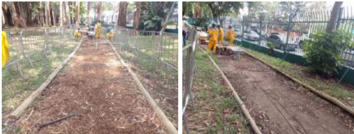
Figura 64 Manutenção Pista de Cooper
