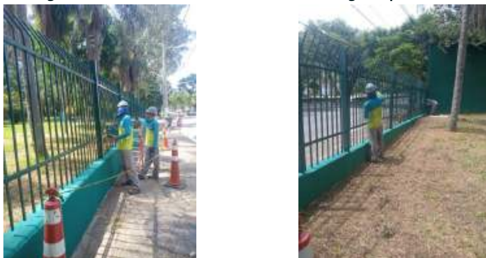
Figura 65 Pintura e reforma de muretas, muro e gradil perimetral
