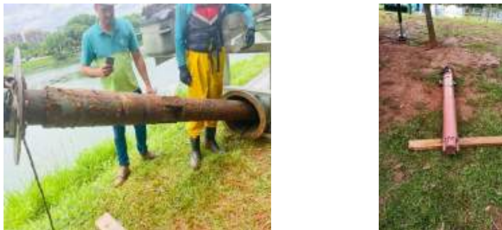
Figura 74 Manutenção Correiva na bomba da Fonte Multimídida
